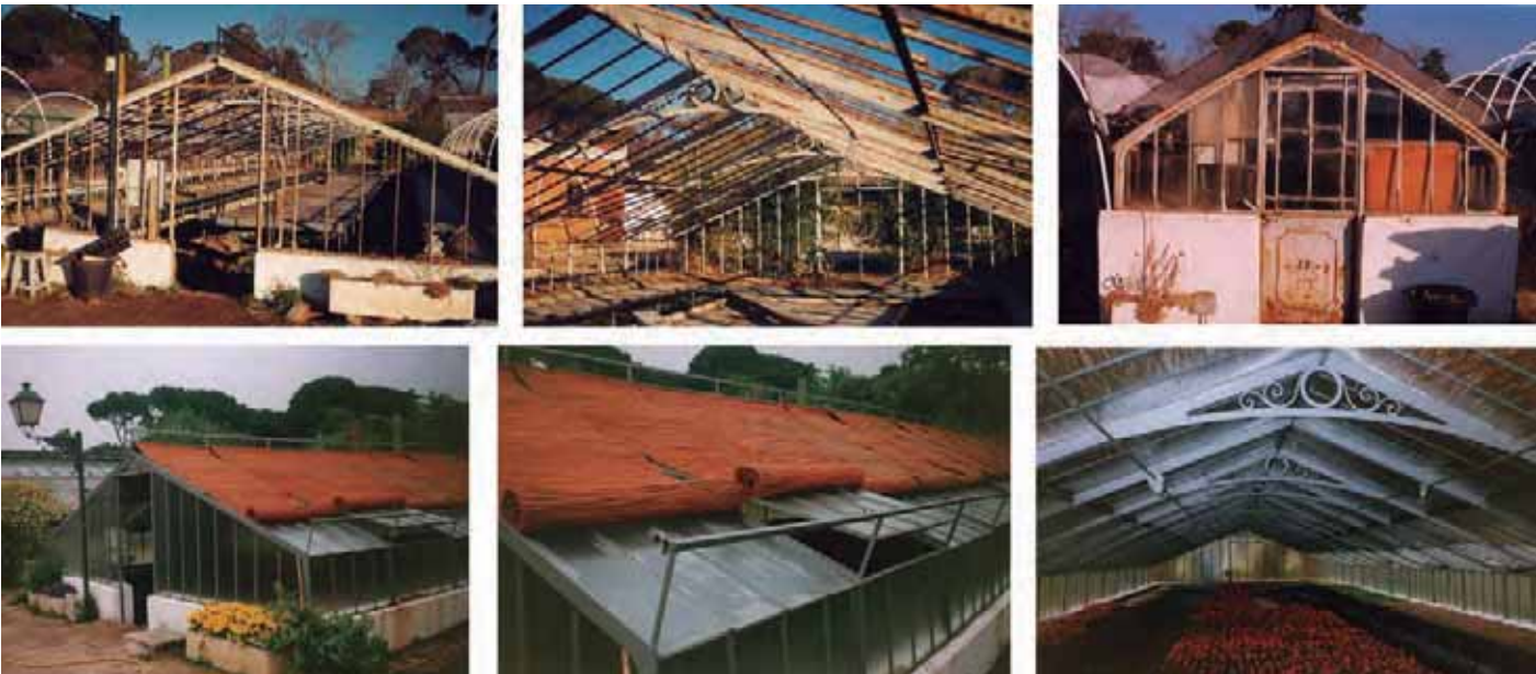
(1) Fig. 128. Los túneles en junio de 2018 [JS].
