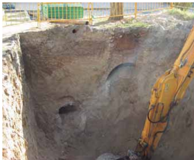
Fig. 125. Galerías subterráneas en el Reservado de estufas, 2010 [JS].
