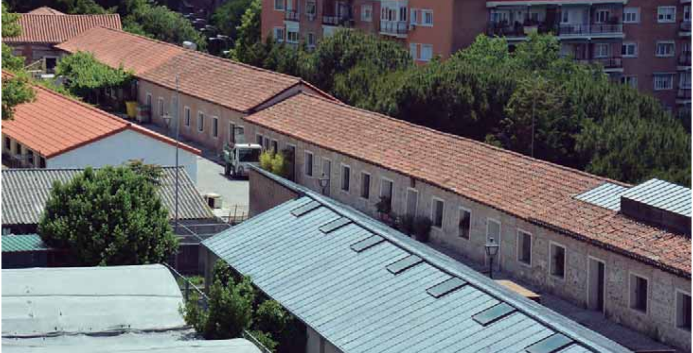
Fig. 107. El edificio de los talleres, hoy albergando otros usos.
