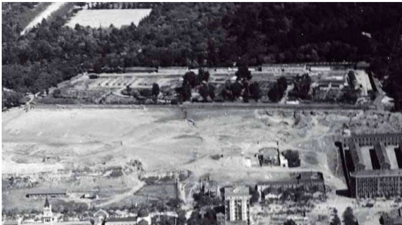
Fig. 75. Fragmento de la vista aérea de la estación ferroviaria de Mediodía (Atocha) en Madrid, c. 1920 [España, Ministerio de Defensa, AHEA, 1-09945-01]. En la imagen se distinguen las estufas adosadas al muro, el grupo de dimensiones más reducidas del extremo noreste y la zona arbolada intermedia.
