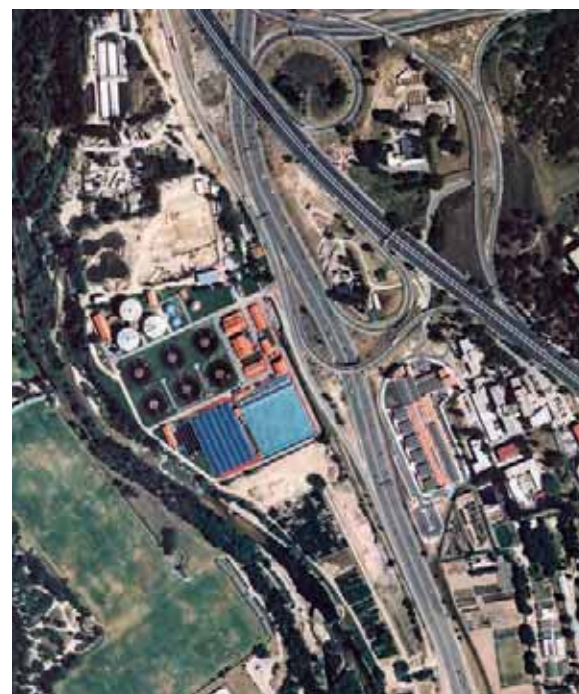
(2) Fig. 53. Inicios de las obras de la tercera ampliación de la depuradora de Viveros, en el vuelo de 1999 [AGDUS, Ayuntamiento de Madrid].
