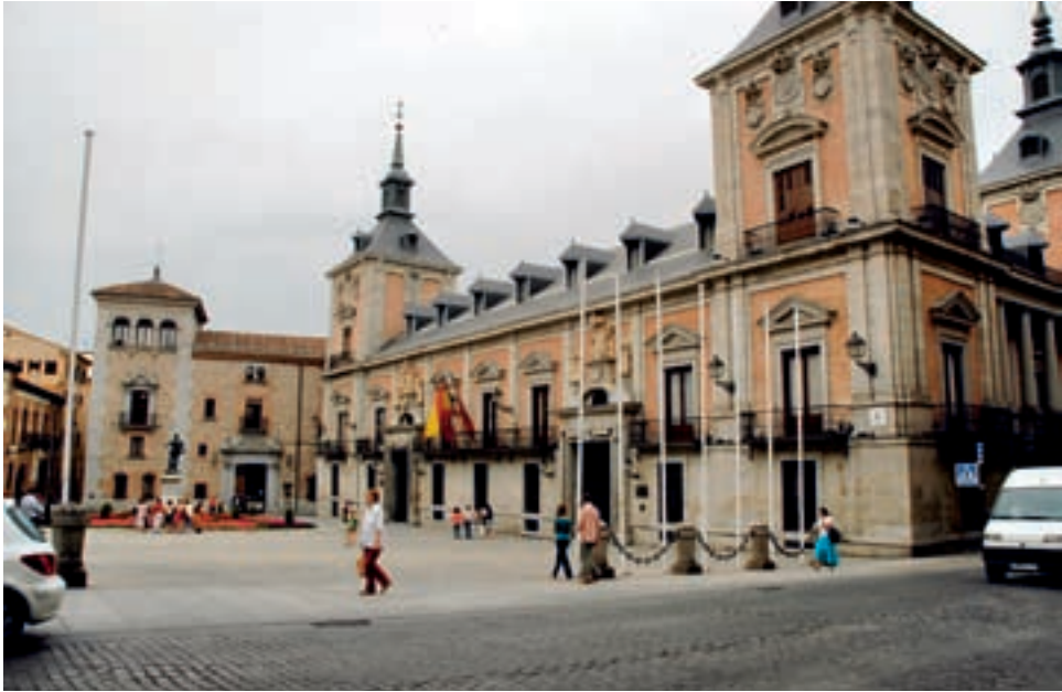
Figura 9. Casa de Ayuntamiento, 1629-1696, Madrid. Diseño de Juan Gómez de Mora, José de Villarreal y Teodoro Ardemans.
