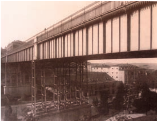
Figura 13. Viaducto sobre la vaguada de Segovia (1872-1883).
