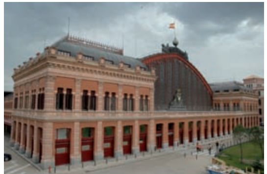
Figura 14. Estación de Atocha. Alberto de Palacio. (Foto Pablo Salgado)
