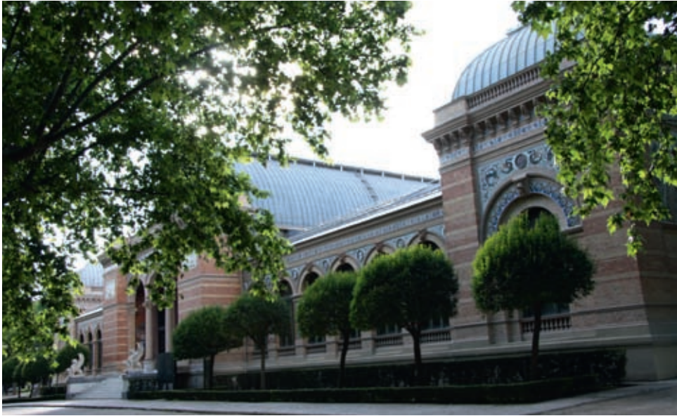
Figura 1. Palacio de Velázquez en el parque del Retiro, obra del arquitecto Ricardo Velázquez Bosco. (Foto M.ª Rosa Cervera).
