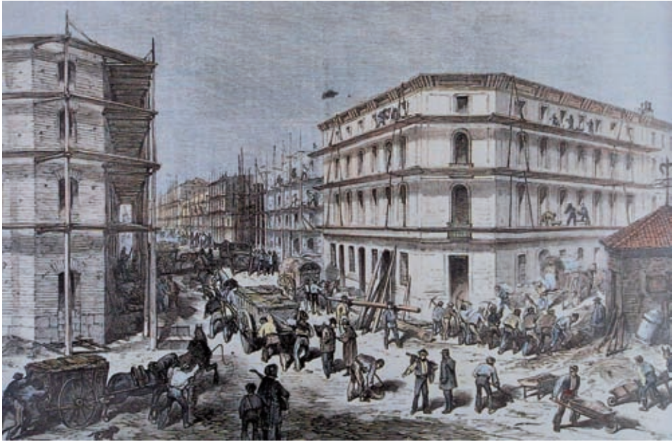
Figura 7. Construcción de los primeros edificios de viviendas en el barrio de Salamanca.
