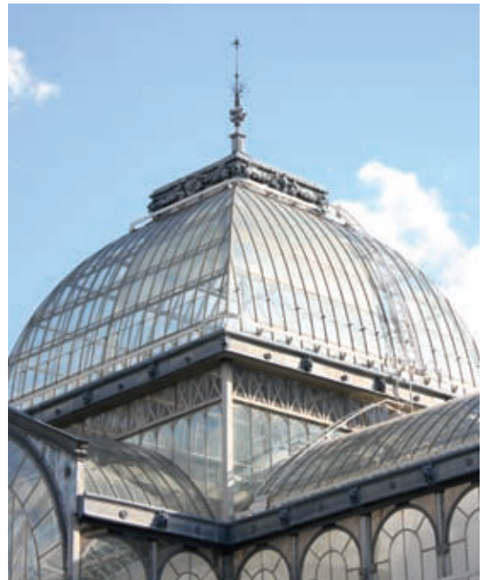
Figura 3. Palacio de Cristal en el Parque del Retiro, obra del arquitecto Ricardo Velázquez Bosco. Detalle de la cubierta. (Foto M. a Rosa Cervera)
